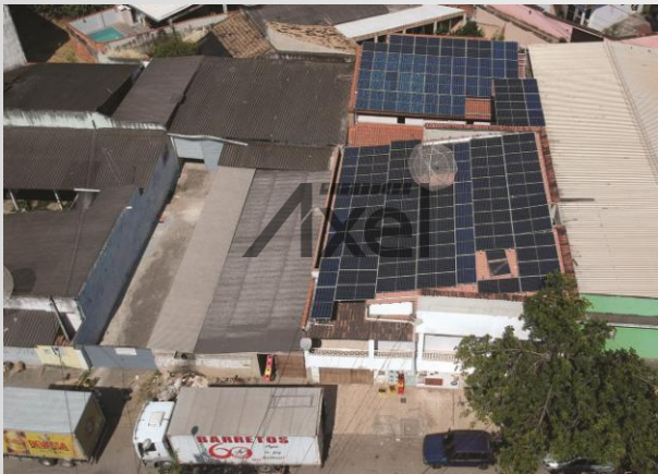
DEPÓSITO DE BEBIDAS DOS PRIMOS – SEROPÉDICA/RJ 42,8 KWP (124 PLACAS)
