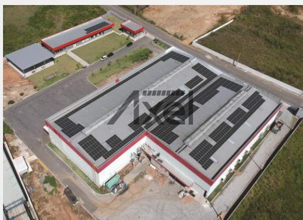
GRÁFICA TMX - SAQUAREMA 273,75KWP (750 PLACAS)
